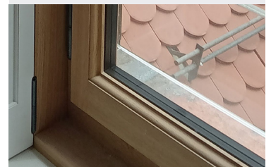
Nouvelle fenêtre triple vitrage et intercalaire discret (foncé)
