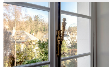
Rénovation fenêtre ancienne avec verre sous-vide 8
