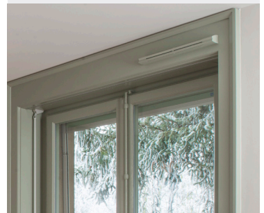
Intégration d'une grille hygro-réglable dans le caisson de store
